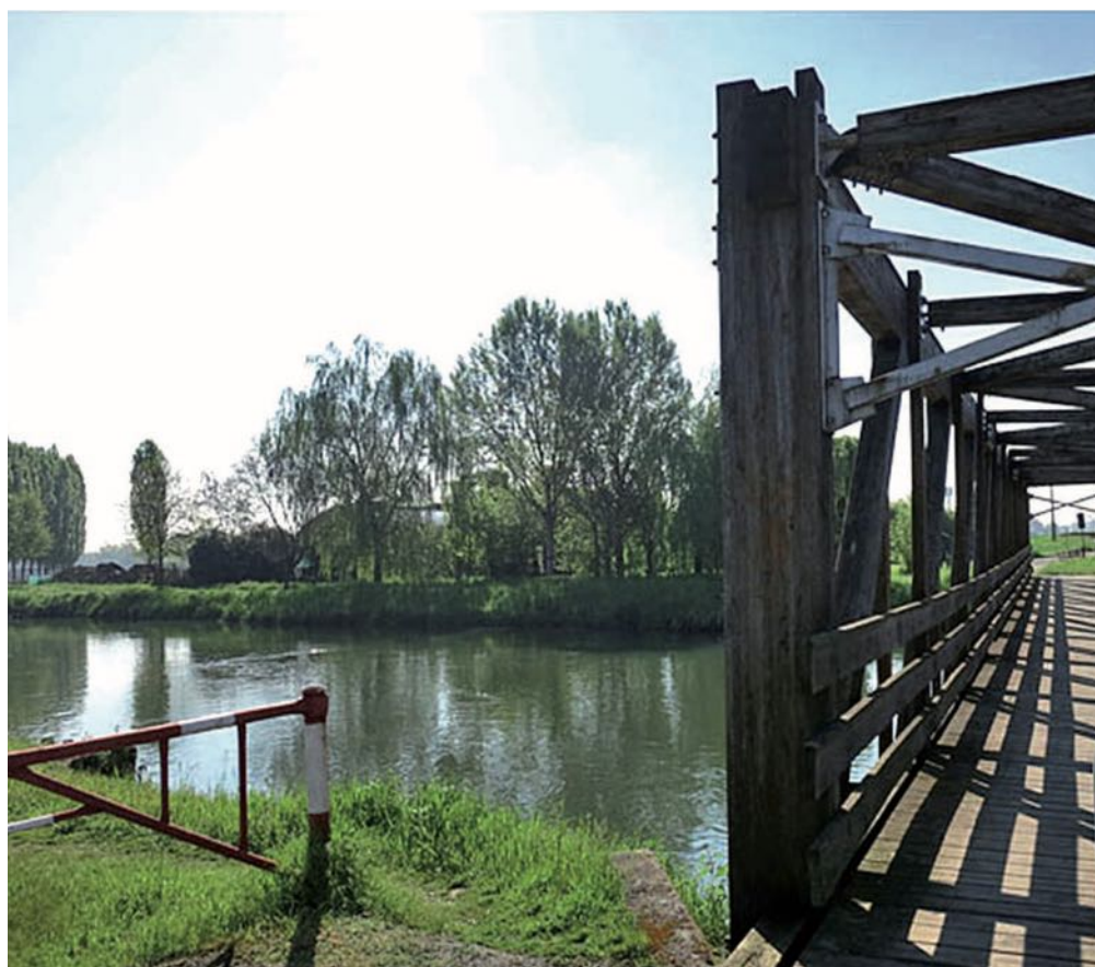
Particolare del canale
