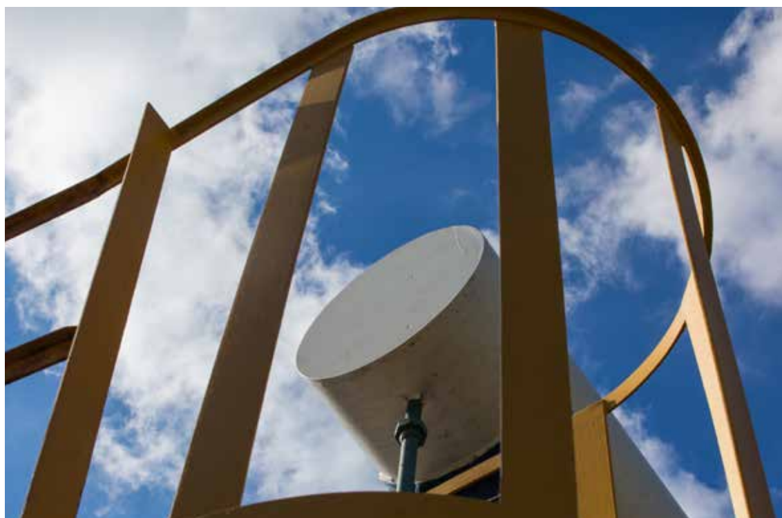
Particolare scala di sicurezza
