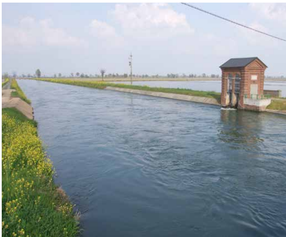
Canale per irrigazione
