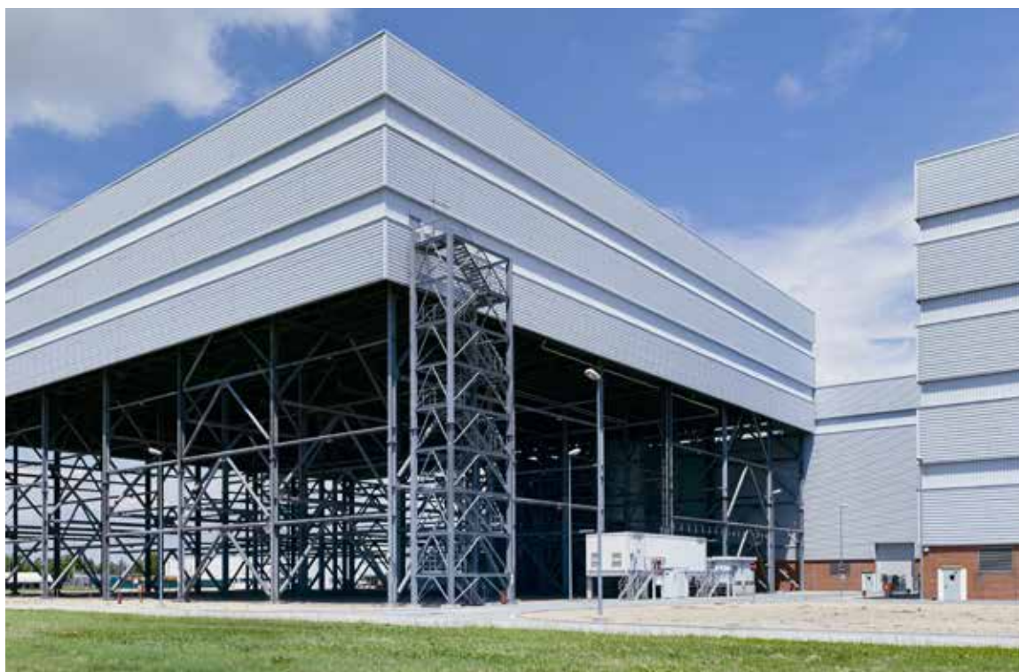
Particolare del rivestimento della centrale
