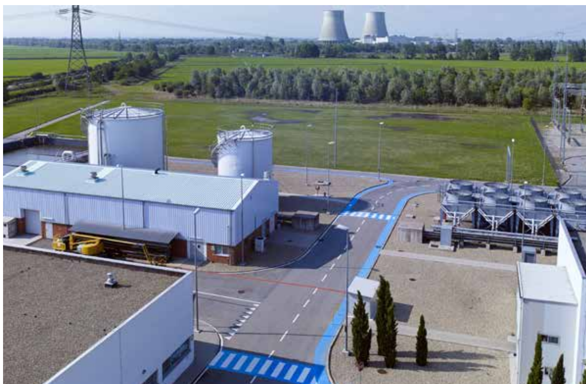
Vista dalle coperture della centrale
