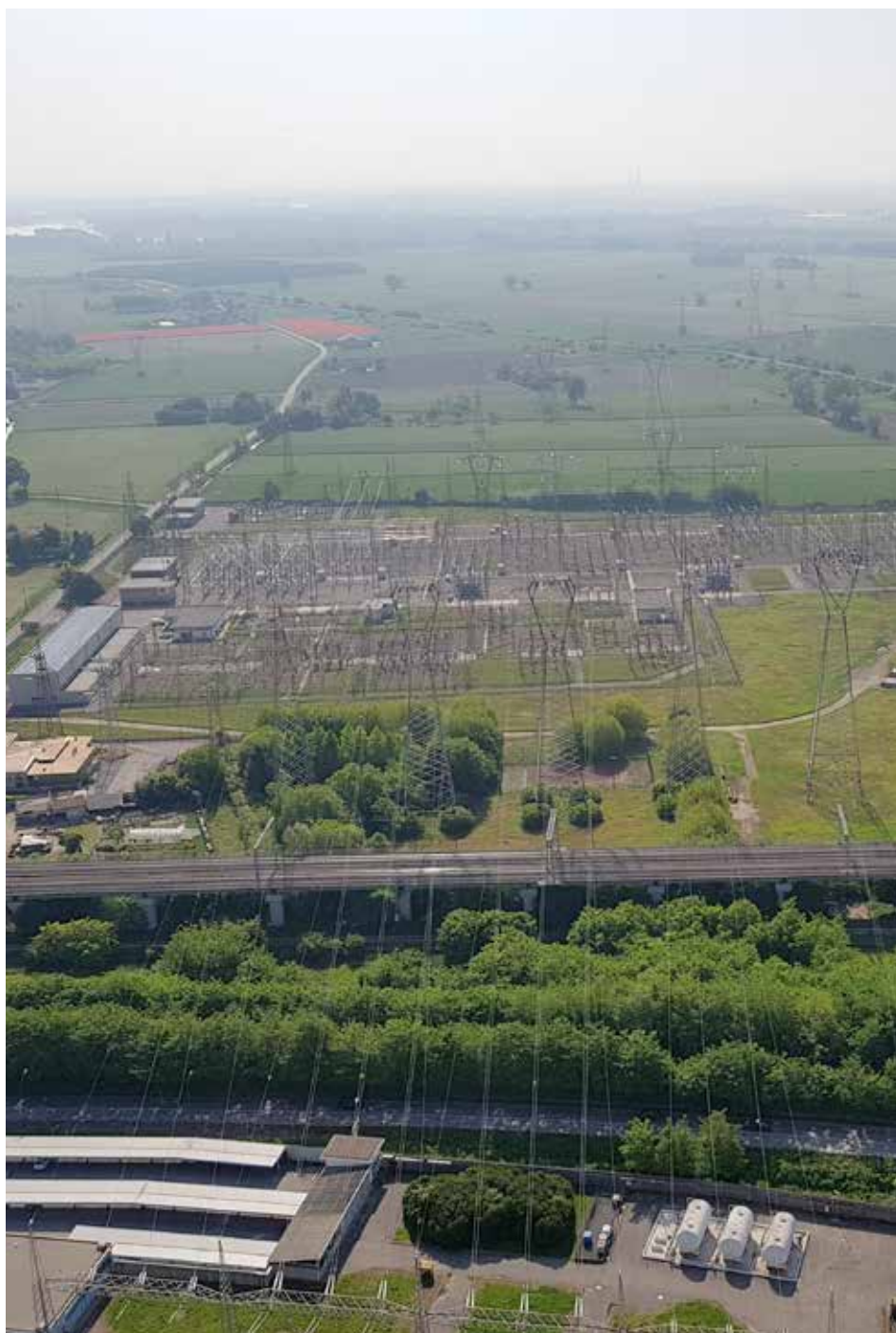
Vista della sottostazione
